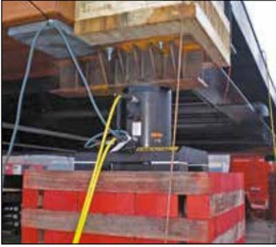
◀ Tipica applicazione di sollevamento a stadi che utilizza un sistema Enerpac costruito appositamente per issare il ponte in legno di Akkerwinde (Paesi Bassi) da 360 tonnellate.
