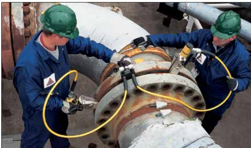
◀ Dois separadores FSH14 usados simultaneamente com a bomba manual, mangueiras e manifold de controle AM21 da Enerpac.
