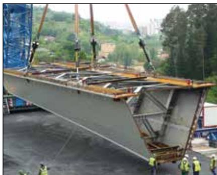
▼ Os engenheiros de rigging usaram o sistema SyncHoist para monitorar e ajustar com precisão cada ponto de içamento de forma independente ou juntos de maneira sincronizada para posicionar o módulo da usina nuclear de 1140 toneladas.
