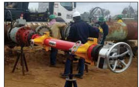
▲ Aplicação de trepanação a quente com a CHT3000 para instalação de dutos petroquímicos.
