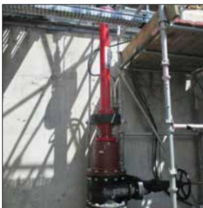
**Máquinas de Trepanação a Quente**
