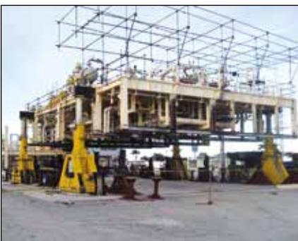
Montage des modules d'une plate-forme pétrolière offshore
