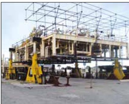
**Assemblaggio di un modulo di una piattaforma petrolifera offshore**
