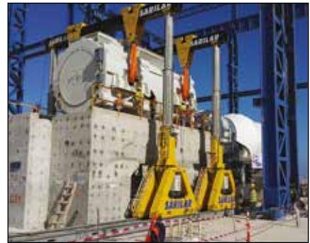
**Installazione di una turbina e di un generatore presso un nuovo impianto di generazione in Libia**
