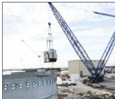
▼ Sistema Enerpac SyncHoist en uso durante la selección de vigas de techo: elevación y posicionamiento precisos de vigas de techo retráctiles del estadio. 33 cerchas con un peso entre 450 y 750 toneladas.
