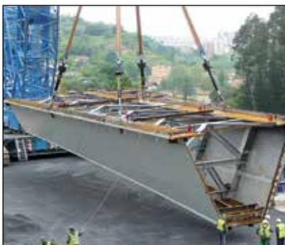
▼ Los ingenieros del aparejo utilizaron el sistema SyncHoist para controlar y ajustar con gran precisión cada punto de elevación independientemente o juntos en una manera sincronizada, para posicionar el módulo de la planta nuclear de 1140 toneladas.
