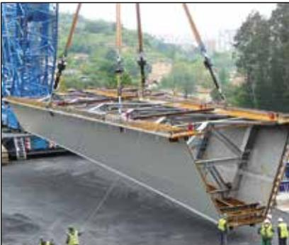
▼ I tecnici hanno utilizzato il sistema SyncHoist per monitorare e regolare con precisione ogni punto di sollevamento singolarmente oppure congiuntamente in modo sincronizzato per il posizionamento del modulo da 1140 ton di un impianto nucleare.
