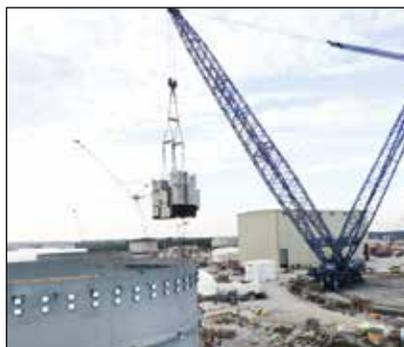
▼ Sistema Enerpac SyncHoist em uso durante a seleção das treliças do telhado: levantamento e posicionamento precisos das treliças retráteis do telhado do estádio. 33 treliças com peso entre 450 - 750 toneladas.
